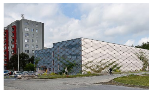
Obyvatelé tábořského sídliště Nad Lužnicí si brzy ulévají díky novému parkovacímu domu pro 241 vozidel (na fotografii projekt). Rozjednané plány na podobné stavby mají také v Budějovicích nebo Jindřichově Hradci – tam radnice plánuje poskytnout vhodné pozemky na sídlišti Vajgar bytovému družstvu, které si podzemní garáže vybuduje na své vlastní náklady.
